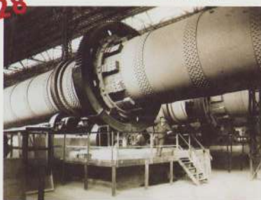
Oven 2. Deze oven levert de eerste ENCI-klinker en zal bijna vijftig jaar in bedrijf blijven.
