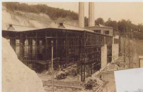
De bouw van ovenhal Noord. Twee schoorstenen zijn nog in aanbouw.
